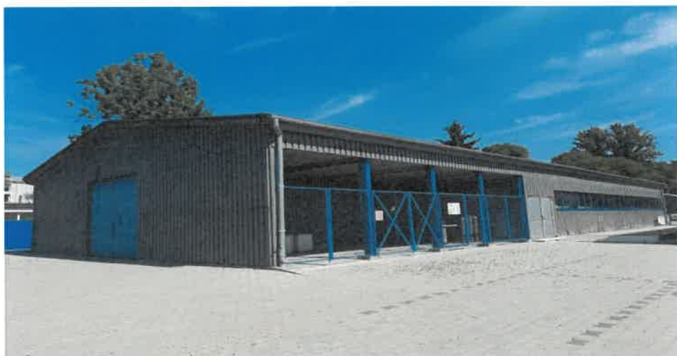
11. Budynek – Magazyn drobnicowy– powierzchnia użytkowa:514m 2 , jedna kondygnacja
