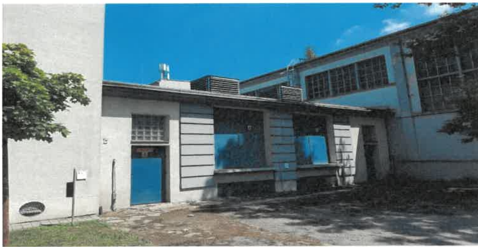
10. Budynek – Transformatorownia– powierzchnia użytkowa:122m 2 , jedna kondygnacja
