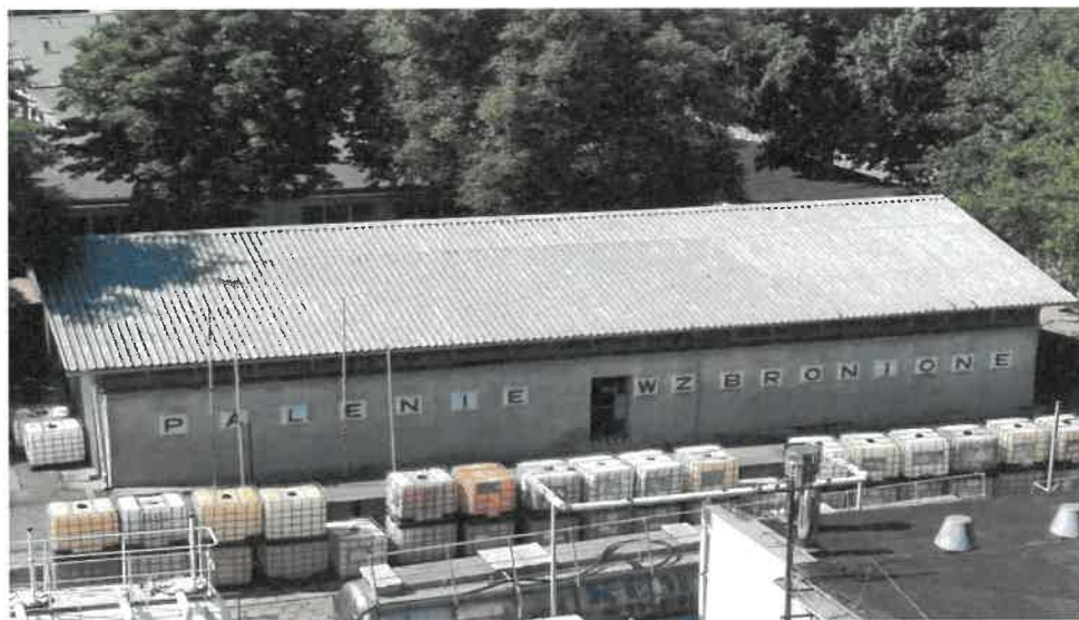
12. Budynek – Magazyn frakcji – powierzchnia użytkowa:262m 2 , jedna kondygnacja
