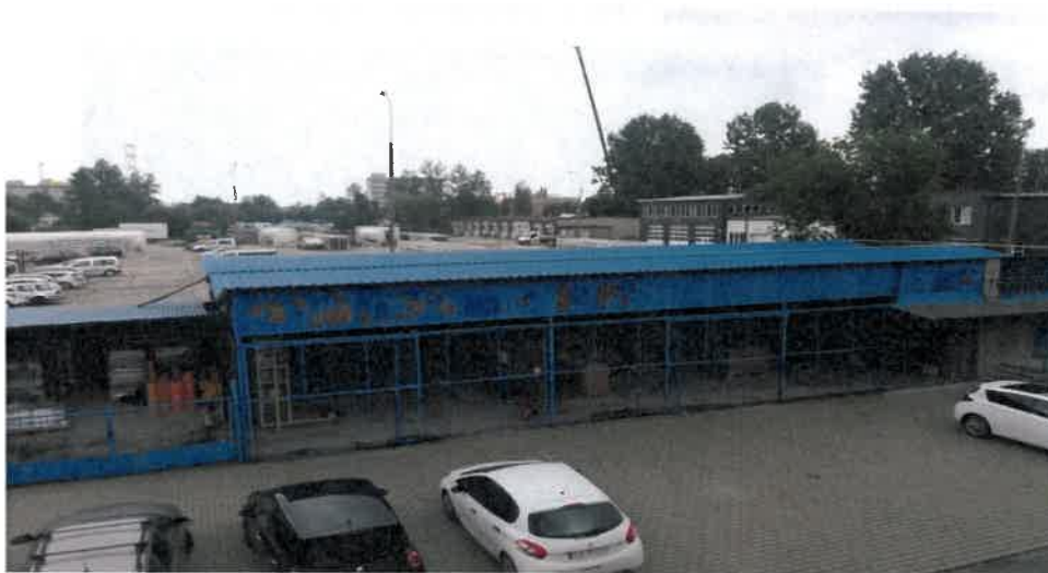
7. Budynek-Magazyn Butli – powierzchnia użytkowa: 72m 2 , jedna kondygnacja
