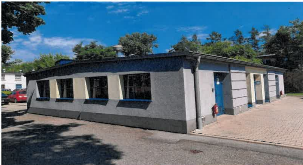
13. Budynek– Magazyn mat. łatwopalnych– powierzchnia użytkowa:103m 2 , jedna kondygnacja
