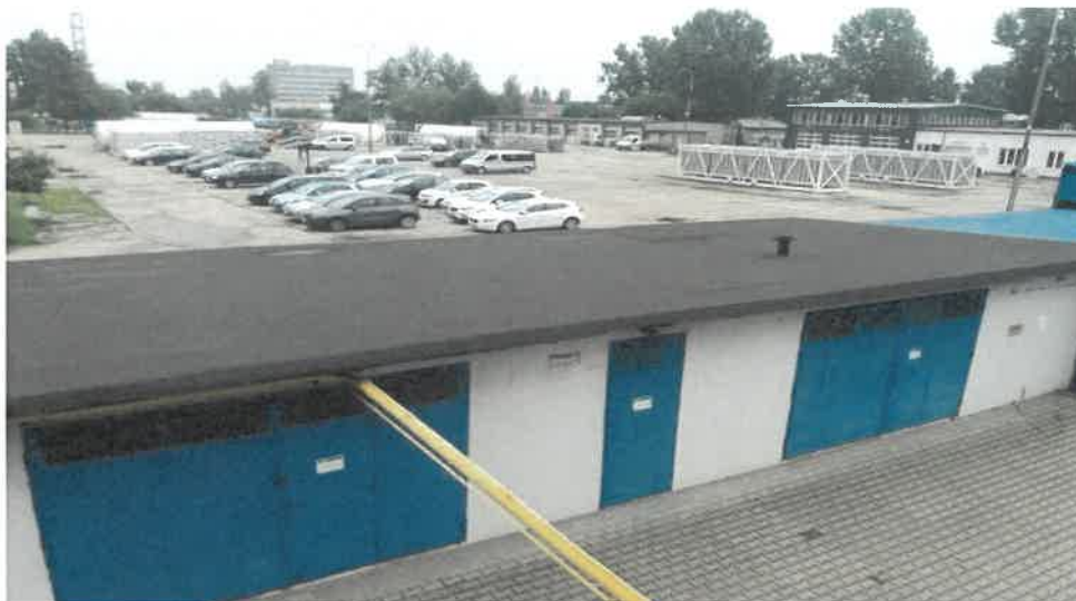
9. Budynek – Barak magazynowy– powierzchnia użytkowa:134m 2 , jedna kondygnacja
