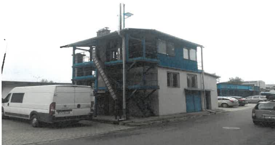
10. Budynek kominów– powierzchnia użytkowa:70m 2 , dwie kondygnacje
