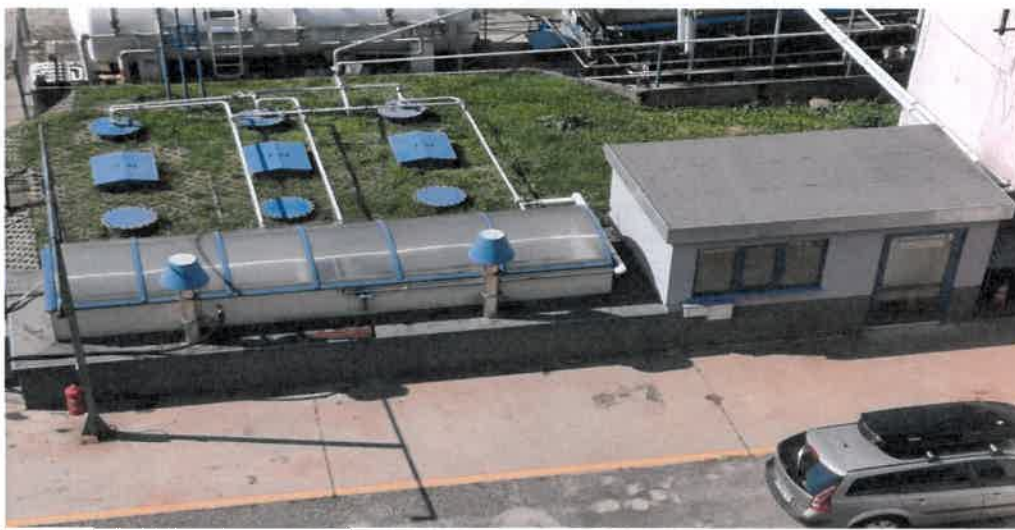
14. Budynek – Przepompownia– powierzchnia użytkowa:24m 2 , dwie kondygnacje
